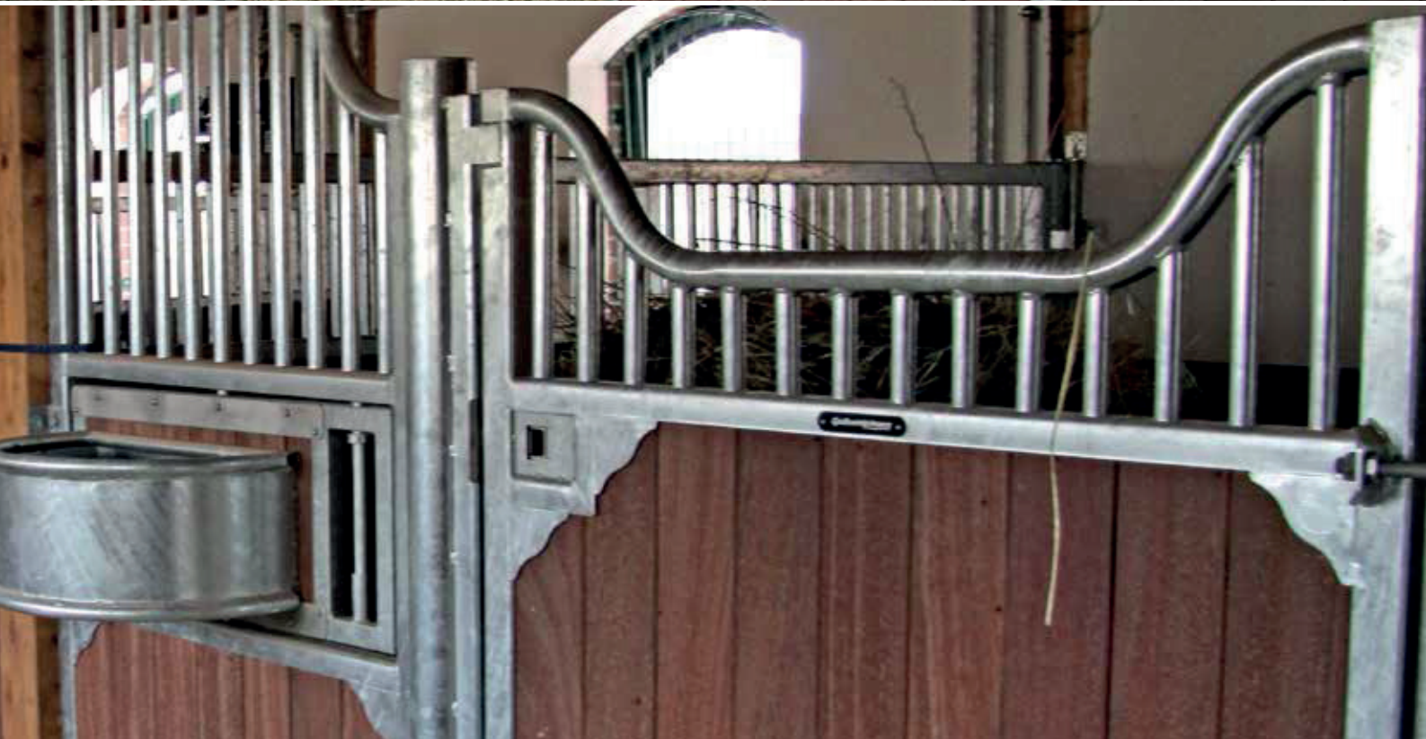
Frontwand Buchela, Holzfüllung Bongossi, und Drehtrogvorrichtung
